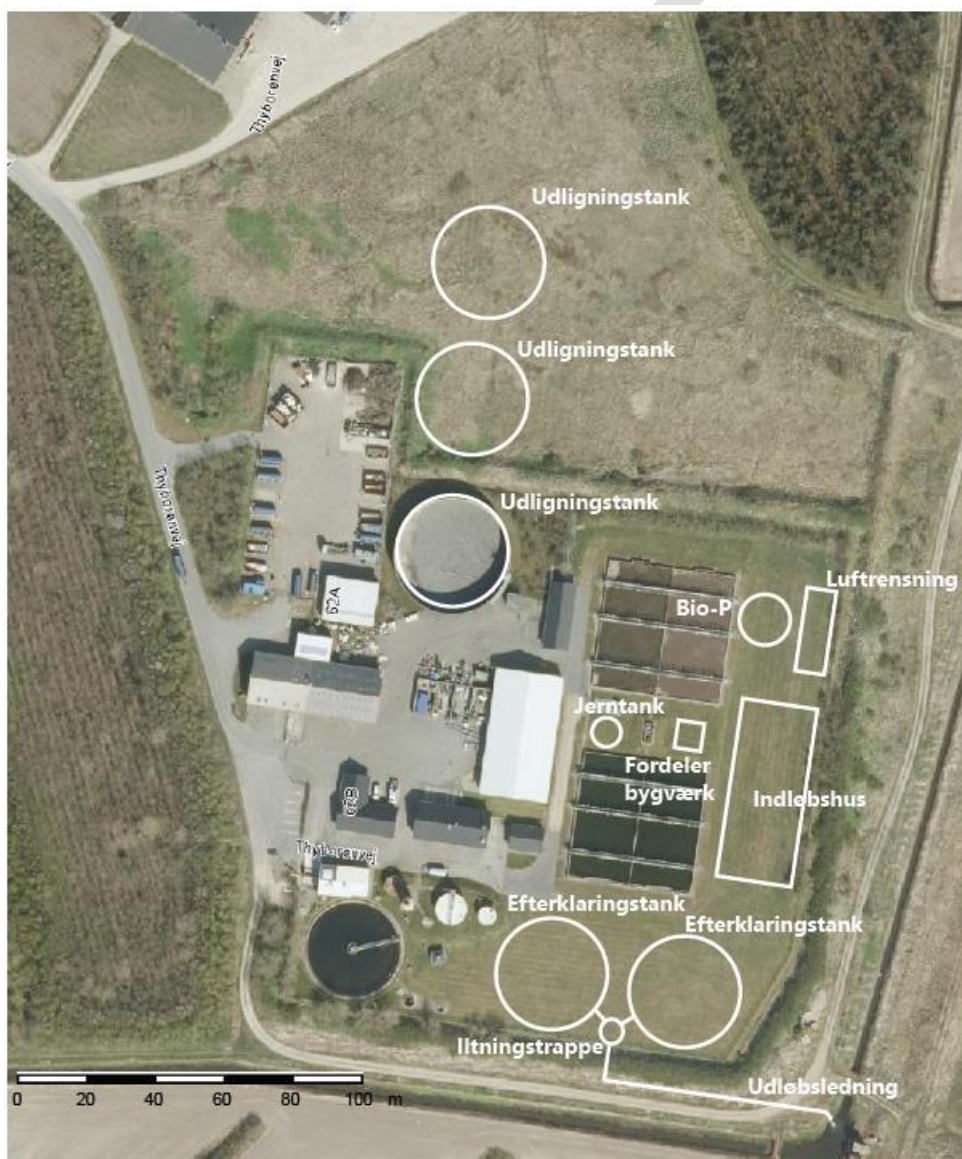
Figur 3 - Luftfoto med nuværende og planlagte anlægsfaciliteter på et udbygget Harbøre Renseanlæg.
