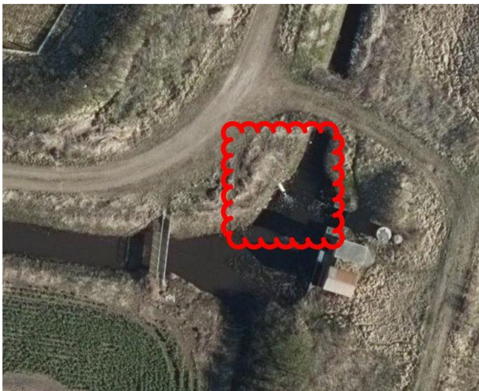
Figur 6 - Udløb fra Harboøre Renseanlæg til Hovedkanal III
